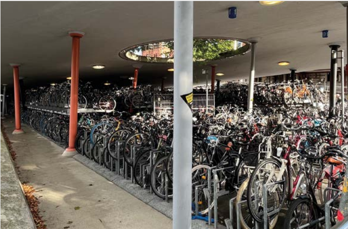
Eines von zwei Fahrradparkhäusern am Bahnhof in Groningen
